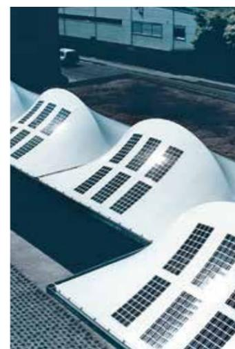
Der perspektivisch am stärksten wachsende Bereich für Photovoltaik ist die gebäudeintegrierte Photovoltaik (GiPV), worunter die
